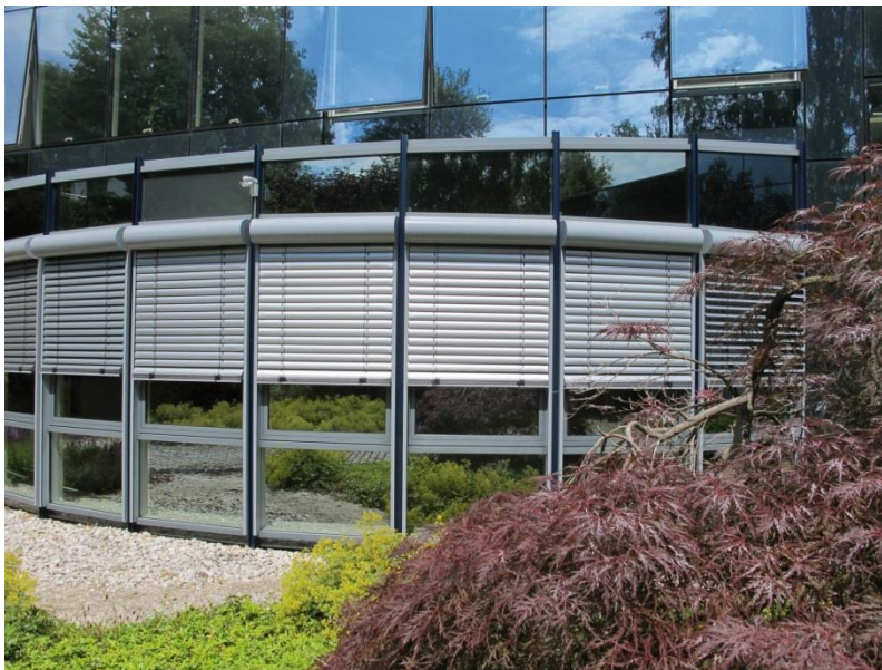
Bild 8: In Vorbaukästen integrierte Raffstoren tragen zu einer modernen Fassadengestaltung bei und sorgen je nach Tages- und Jahreszeit für optimale Licht- und Wärmeverhältnisse im Rauminneren.
