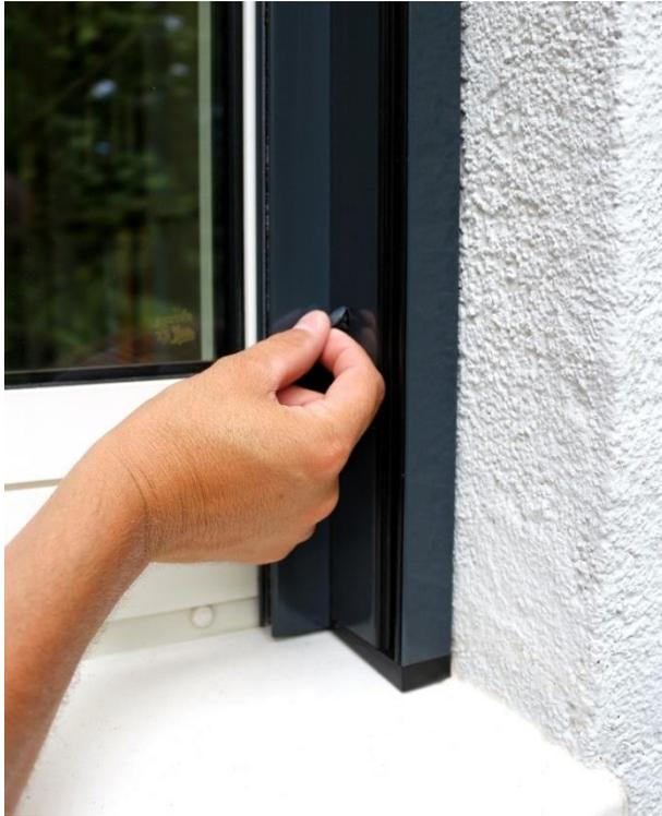
**Bild 10:** Im letzten Schritt werden die mitgelieferten und im passenden RAL-Ton lackierten Abdeckkappen zum Verschießen der Schraubbohrungen in den Führungsschienen eingeklipst. Nach einer fachmännischen Funktionsprüfung ist die Montage des Raff-E abgeschlossen.
