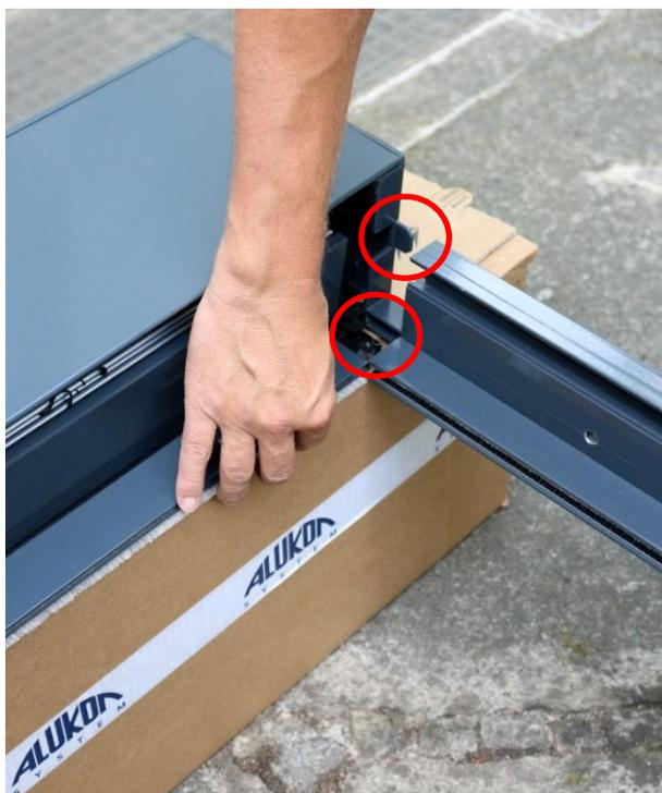
**Bild 2:** Bei Auslieferung des Raff-E sind das Lamellenpaket und in dieser Ausführung ein optional erhältliches Insektenschutzrollo bereits werkseitig im Kasten integriert sowie die Grund- und Führungsschienen so vorbereitet, dass direkt mit
