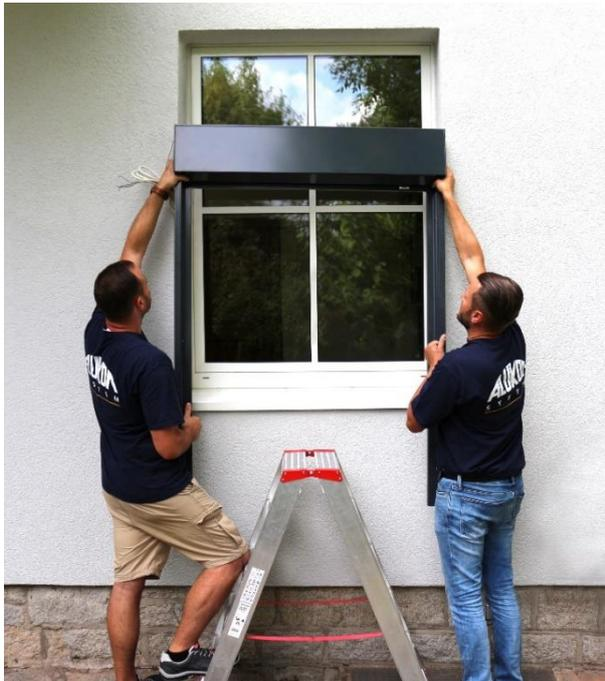
**Bild 3:** Bei der Variante als sichtbarer Kasten in der Laibung wird der Raff-E für die weitere Montage als komplettes Element in die Fensterlaibung gestellt.
