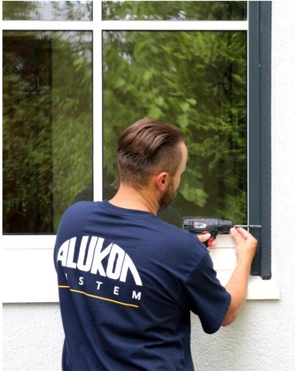
**Bild 5:** Wenn sichergestellt ist, dass das Element waagrecht eingebaut ist, werden die Grundschiene festgeschraubt und so mit der Fensterlaibung verbunden. Die schlagregendicht konstruierten Aluminium-Grundschiene des Raff-E können nach der Montage auch überputzt werden.
