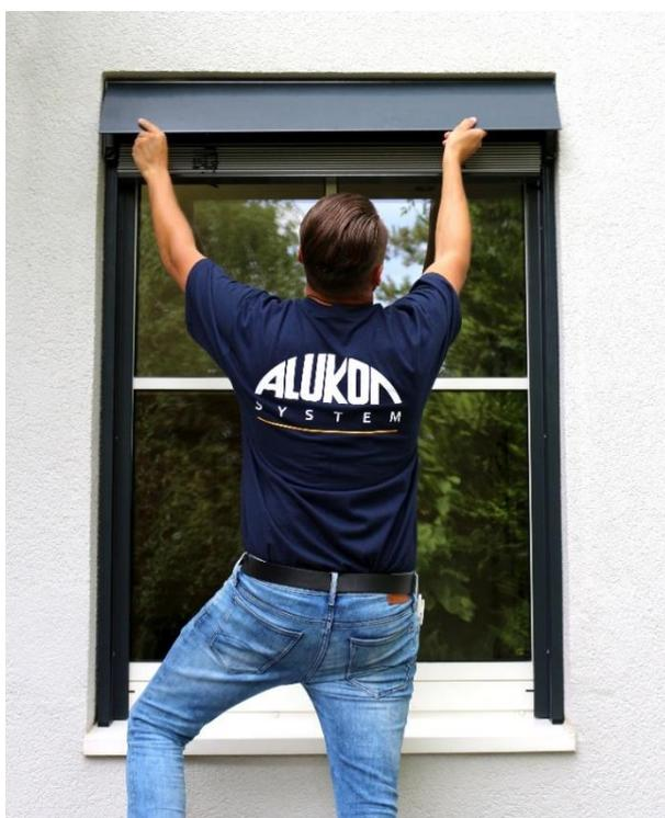
**Bild 9:** Im Anschluss wird die Blende des Raff-E durch zwei verdeckt liegende Schrauben befestigt. Durch die verdeckte Blendenbefestigung sind an der Vorderseite des Kastens keine Schrauben oder Nieten sichtbar. Trotz dessen ist der Kasten für Montage- und Wartungsarbeiten gut zugänglich, indem die Blende durch die zwei Schrauben schnell und einfach geöffnet werden kann.
