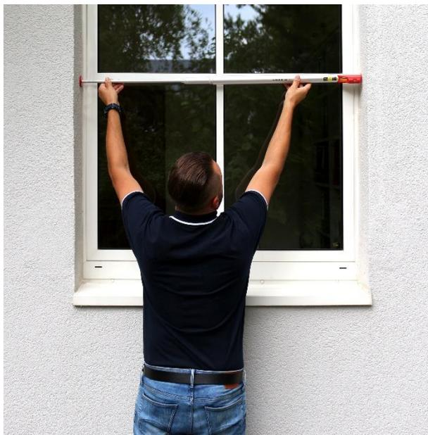
**Bild 1:** Beim Raff-E wird die Elementgröße einfach durch das lichte Öffnungsmaß (Breite x Höhe) ohne komplizierte Berechnungen bestimmt und ist somit auch ohne tieferegehende technische Produktkenntnisse möglich. So können Alukon Partner bereits vor der Montage Zeit sparen und Fehler beim Aufmaß vermeiden.
